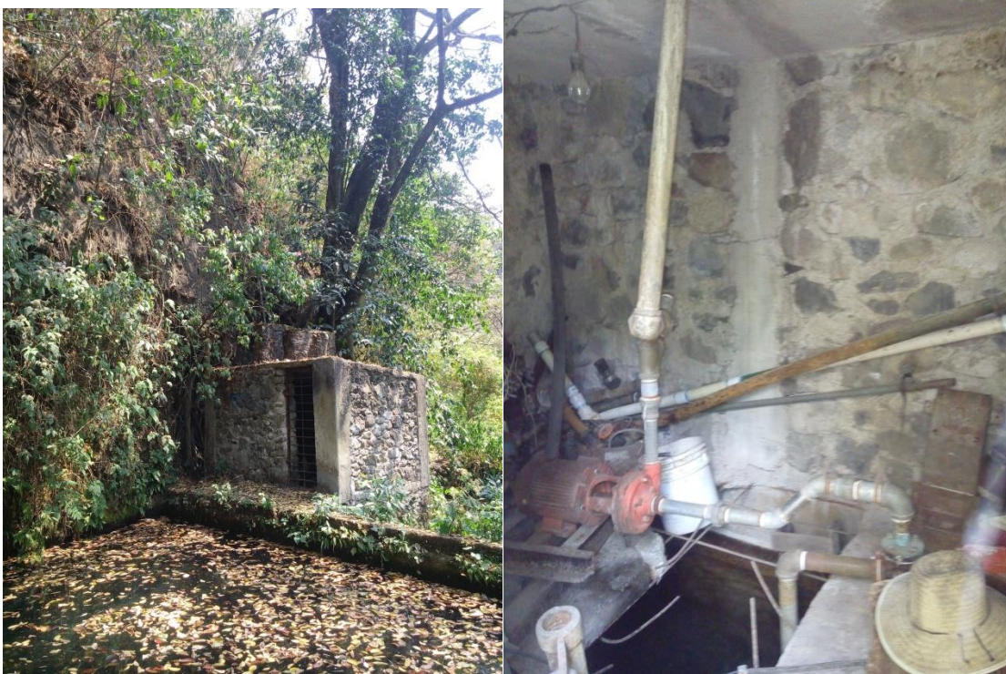
Figura 15. Represa y Bombeo de agua de la barranca Chalchihuapan a la colonia Santa Elena De la Cruz, AGEB: 170070001051A.
