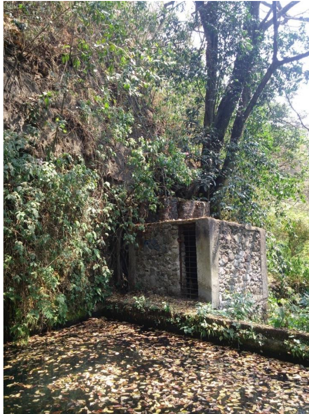
Figura 52. Puesto de bombeo del Manantial de Chalchihuapan.
