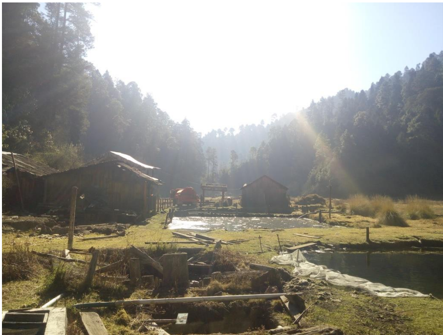
Figura 14. Captación del manantial en zona Atexcapa, al fondo se observa una pipa de agua potable.
